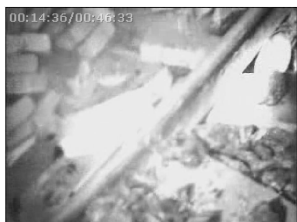
(d) 爆炸冲垮的密闭墙
