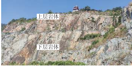
图 1 露天矿边坡现场 Fig. 1 Open pit slope site
