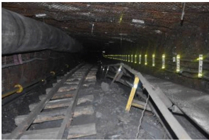
(a) 爆破切顶前
